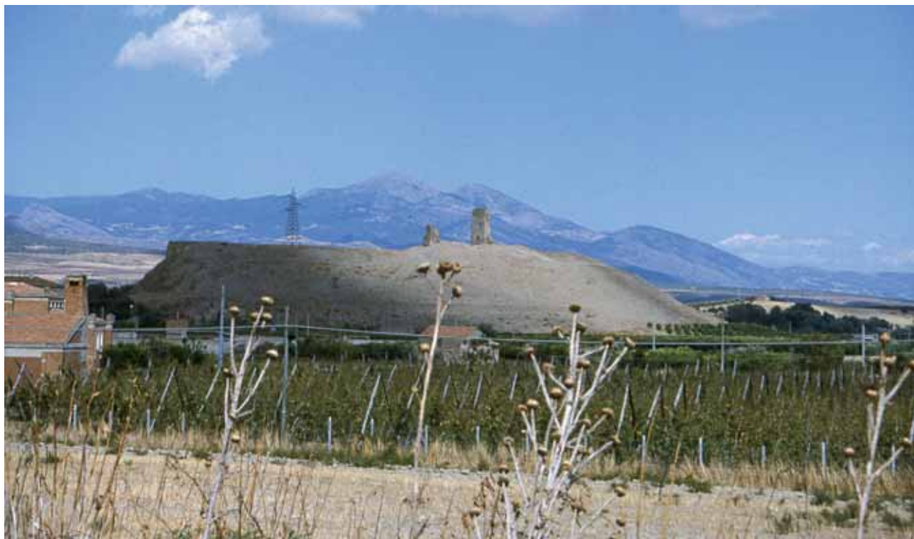
Fig. 1 – La colline du Torrione portant les ruines du château de Scribla vue du sud.
