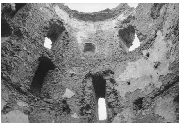
Fig. 4 – Vue intérieure du donjon de Malvito.
